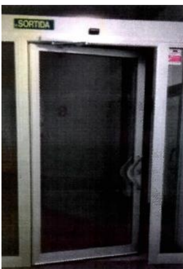
La puerta actual es automática es la única puerta que hay para acceder al edificio. Los mecanismos de apertura están a ambos lados de la puerta
