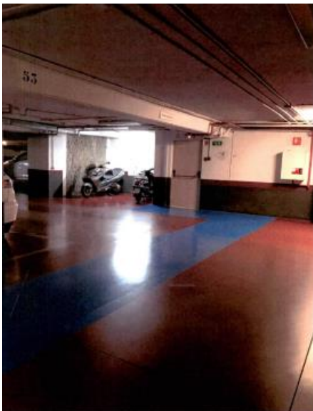
Itinerario para personas con movilidad reducida marcado, en el suelo del garaje de sótano -2, con pintura azul.
