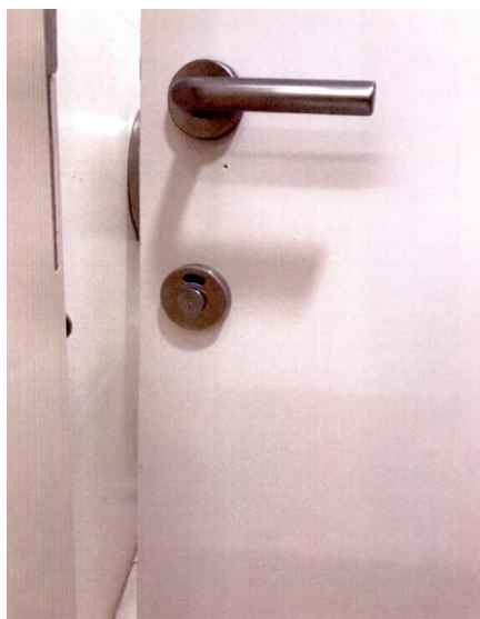
Cambio de sistema de cierre en cabinas con señalización táctil y visual de libre/ocupado.
