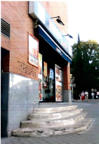
Acceso al establecimiento desde la calle Eugenia de Montijo.
