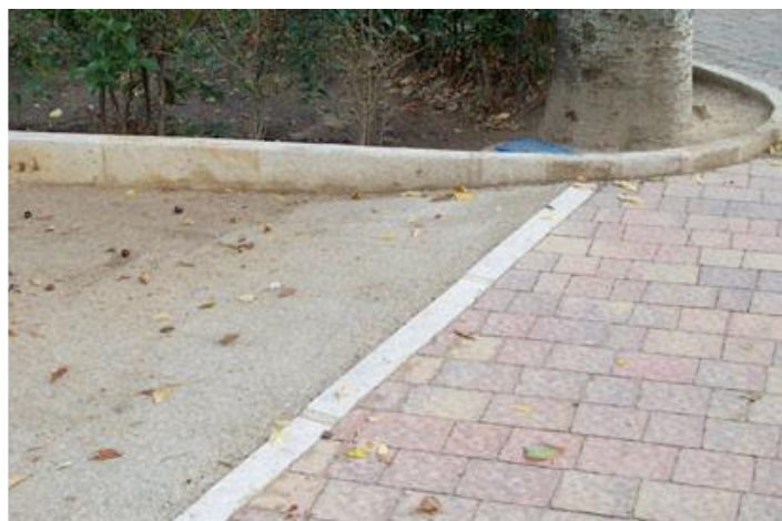
Figura 17- Distintos suelos y pavimentos en el Parque de San Julian (Cuenca); la banda de borde desempeña un papel importante como elemento delimitador. (foto: JA Juncà Ubierna)
