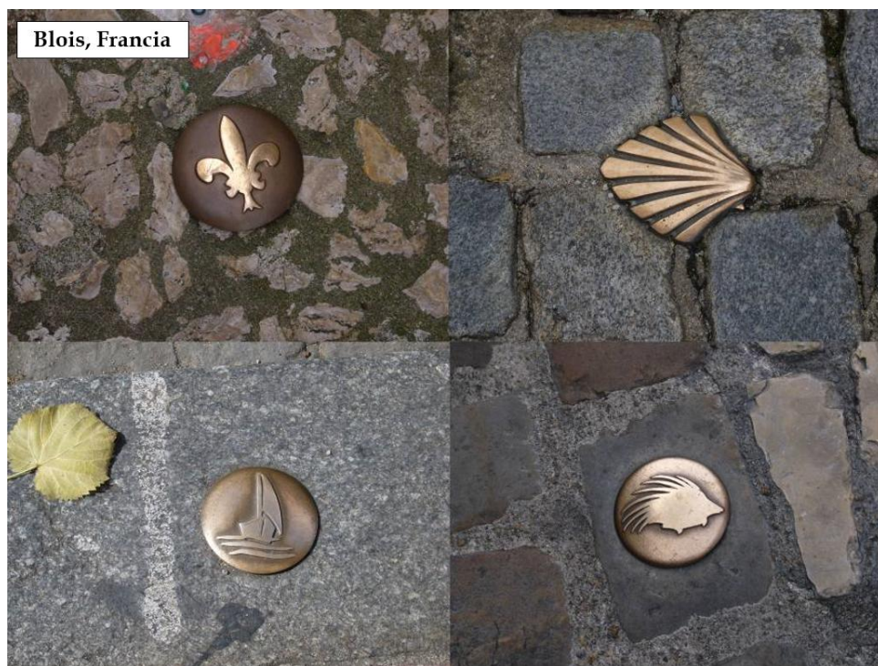
Figura XX- Placas en los pavimentos para la señalización de itinerarios específicos que se pueden encontrar en la ciudad de Blois. Es una solución discreta y eficaz.
