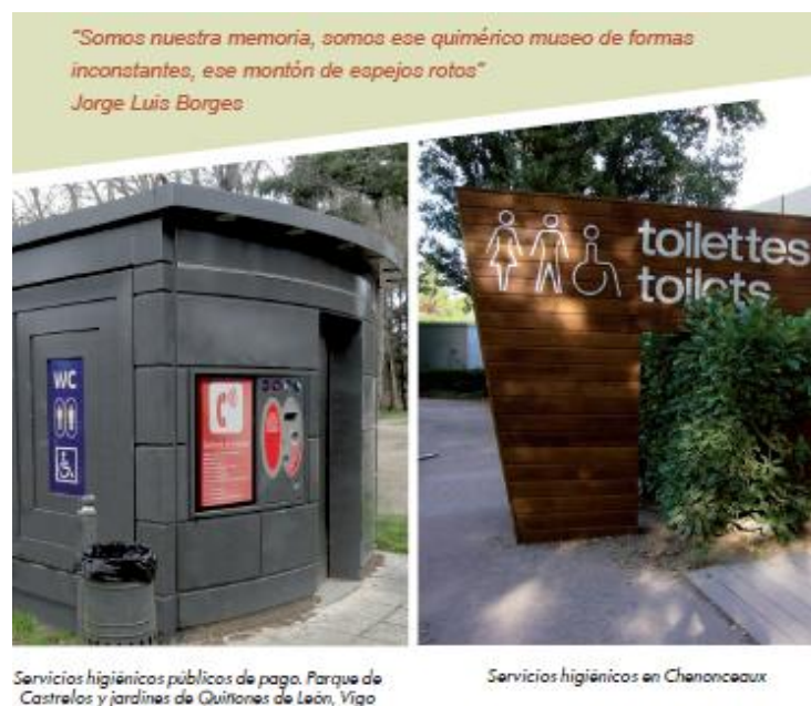
Figura 21- Servicios higiénicos accesibles (fotos: JA Juncà Ubierna)
