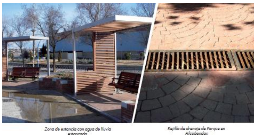
Figura 18- Suelos con agua de lluvia estancada y rejilla de drenaje en una senda(fotos: JA Juncà Ubierna)
