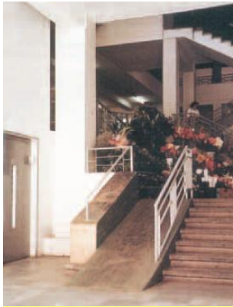
Imagen xx- Rampa inadecuada (rampa-trampa) en la actualidad demolida y reemplazada por una solución adecuada.
