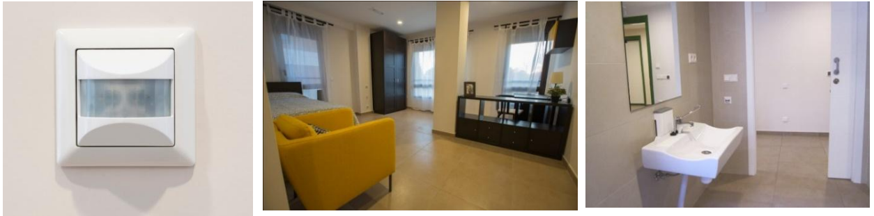
Figura 11- Detectores de caídas en dormitorio y baño
