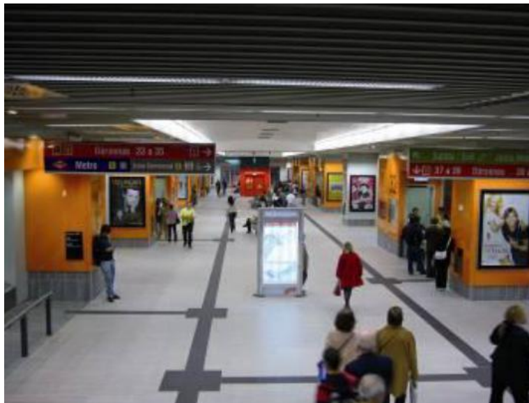
Figura 5- Franjas-guía de encaminamiento en el Intercambiador de Moncloa, Madrid.
