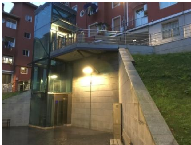
Figura xx- Refuerzo de la iluminación en zonas más escondidas como este acceso a un ascensor en vía pública.
