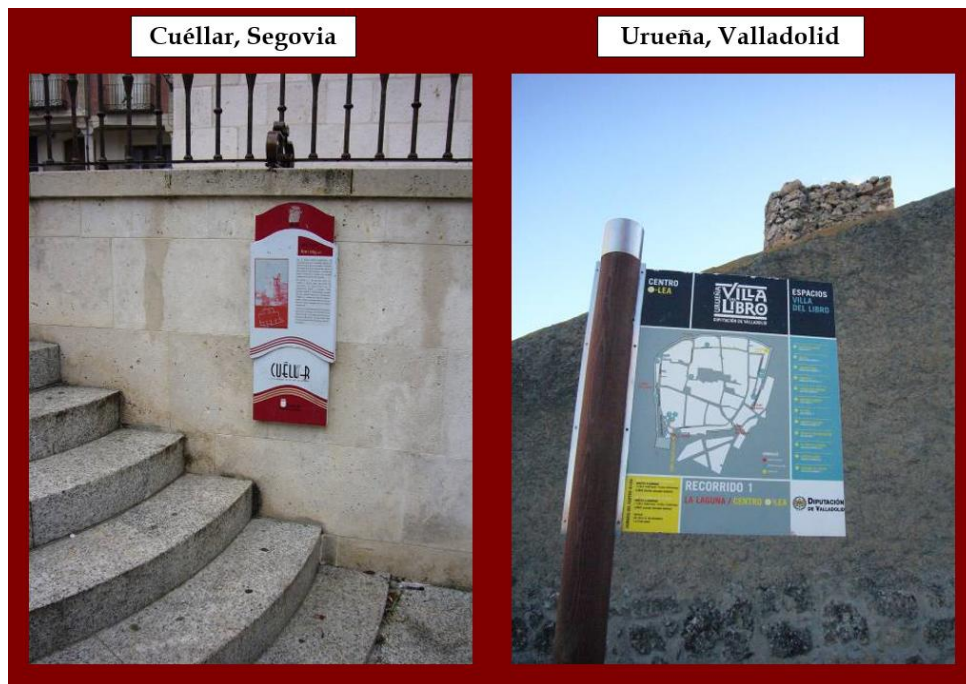
FiguraXX- Ejemplos de elementos de señalización informativa en los que pueden apreciarse aspectos mejorables: Así, a la izquierda se aprecia una ubicación inadecuada del panel informativo, en el tramo de unas escaleras, lo que puede generar riesgos de caídas, tropiezos y entorpecer el paso a otros viandantes; en el panel de la derecha se aprecia que la altura del panel en la banderola es excesiva, el tamaño de letra y el contraste no permiten una fácil lectura y consulta del plano.
