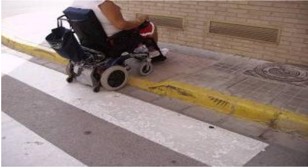
Figura xx- Inadecuada resolución de vado peatonal en acera estrecha, que impide la maniobra de una persona en silla de ruedas, comprometiendo su seguridad.
