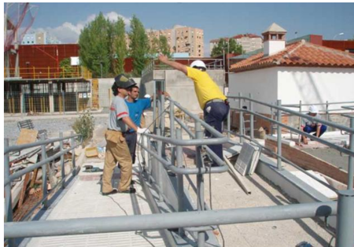
Imagen xx- Ejecución de rampa en un curso de formación de encargados de obra y oficiales de primera.
